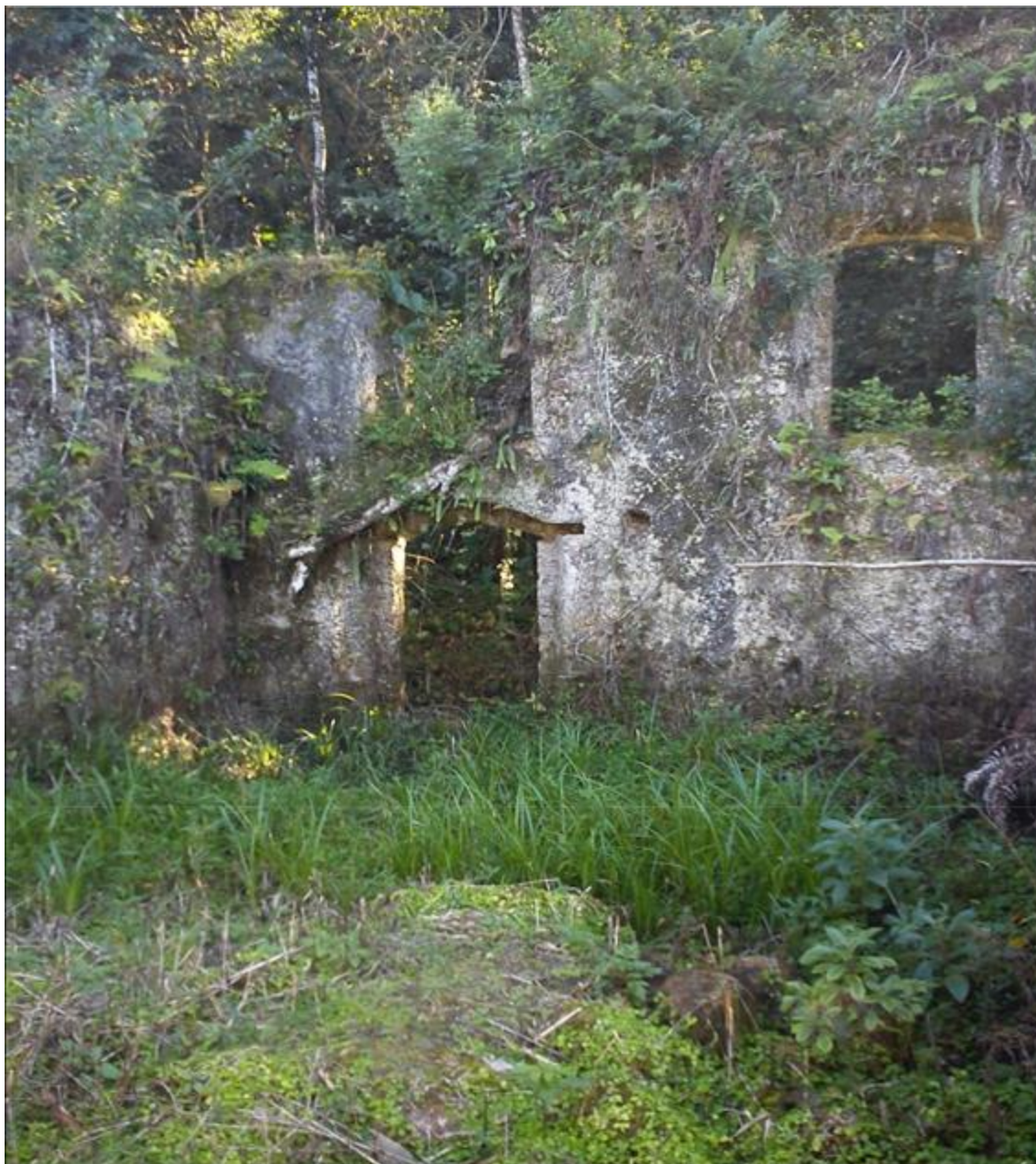
Figura 6 - Interior das ruínas da Casa de Pedra
