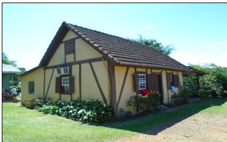
Figura 8 - Casa típica dos moradores da Vila Germânica Picada 48 Alta.
