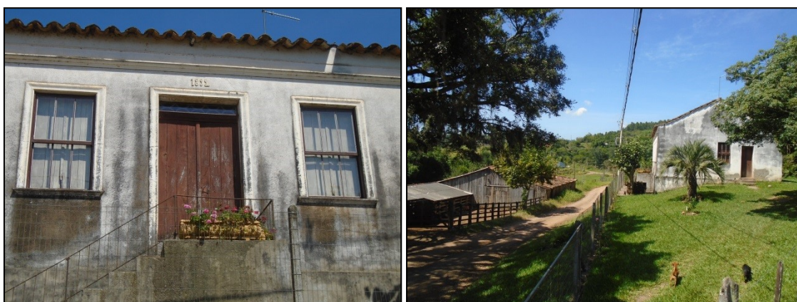
Figura 1 - Parte frontal da casa e rua onde se localiza a casa.
