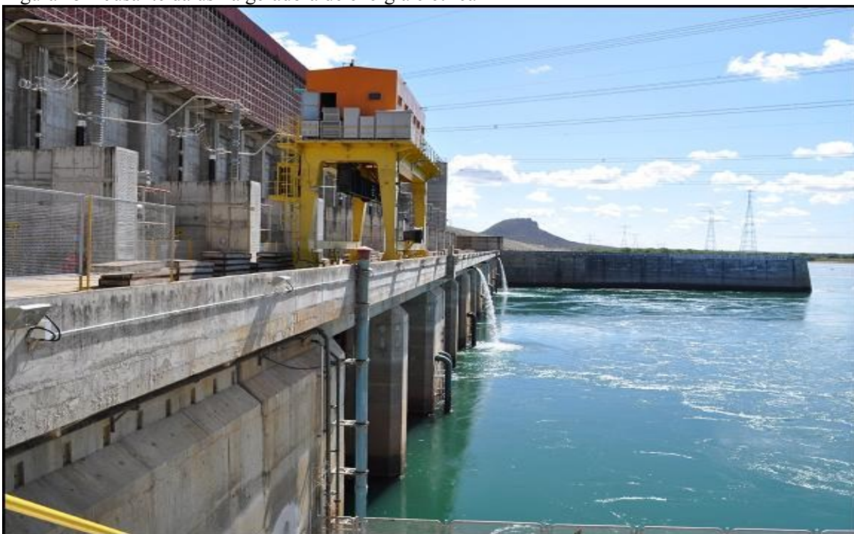
Figura 15 – Jusante da usina geradora de energia elétrica
