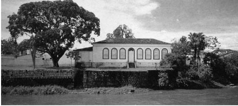
Figura 3: Vista da frente da casa voltada para o rio Nhundiaquara. Fonte: ORGANISMO, 2013
