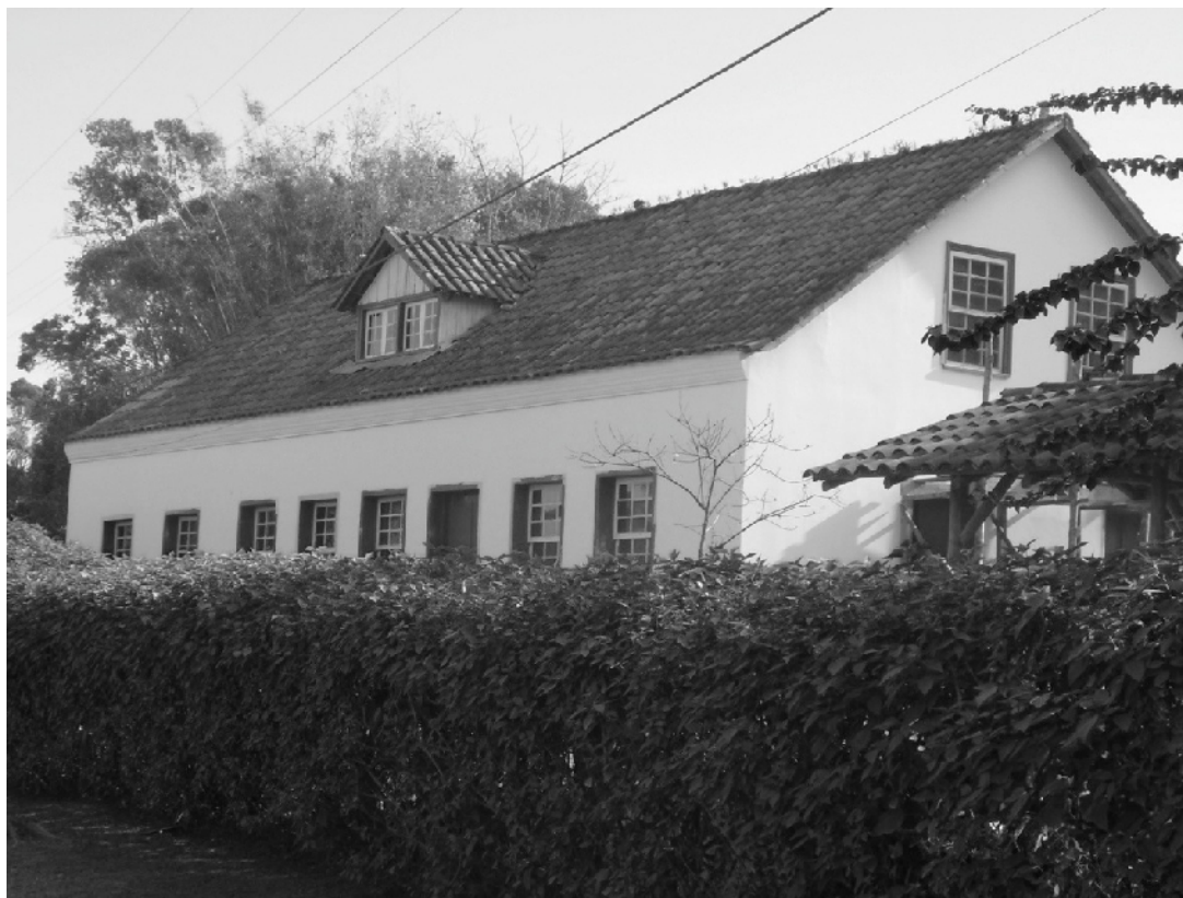
Figura 2 – Maior residência da ocorrência Estaleiro 1.
