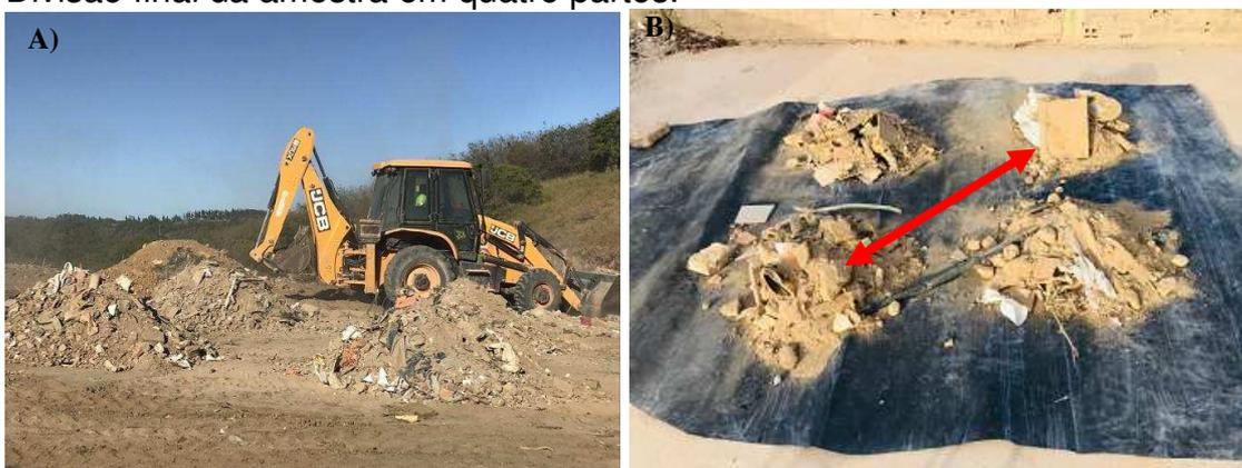
Cada amostra foi acondicionada em baldes e transportada por meio de uma pá mecânica até pátio coberto no aterro sanitário, onde foi realizado o processo de separação, peneiramento e pesagem por tipo de material.
