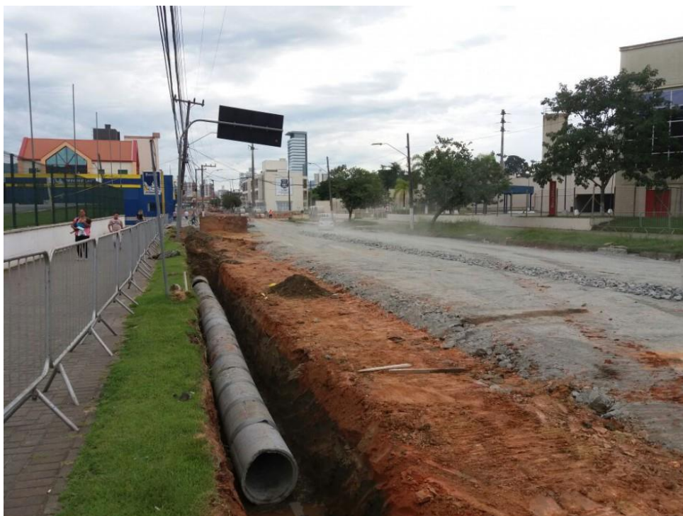
Figura 06– Projeto de drenagem em Blumenau.
