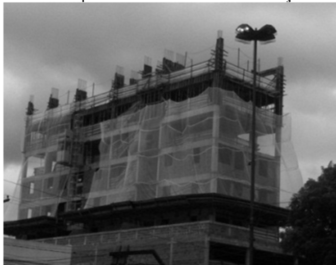
Figura 4 – Fase de acompanhamento da obra: execução de pavimento tipo
