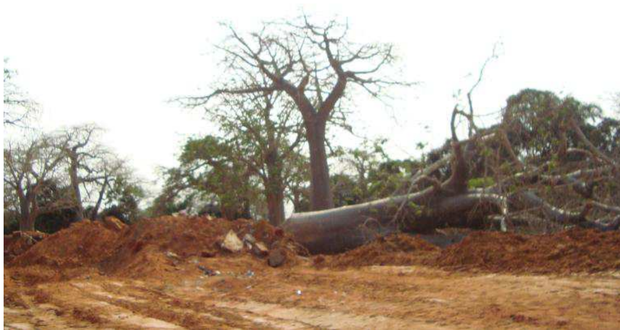
Figura 20: Derrubada de árvores em terraplanagem Foto do Autor
