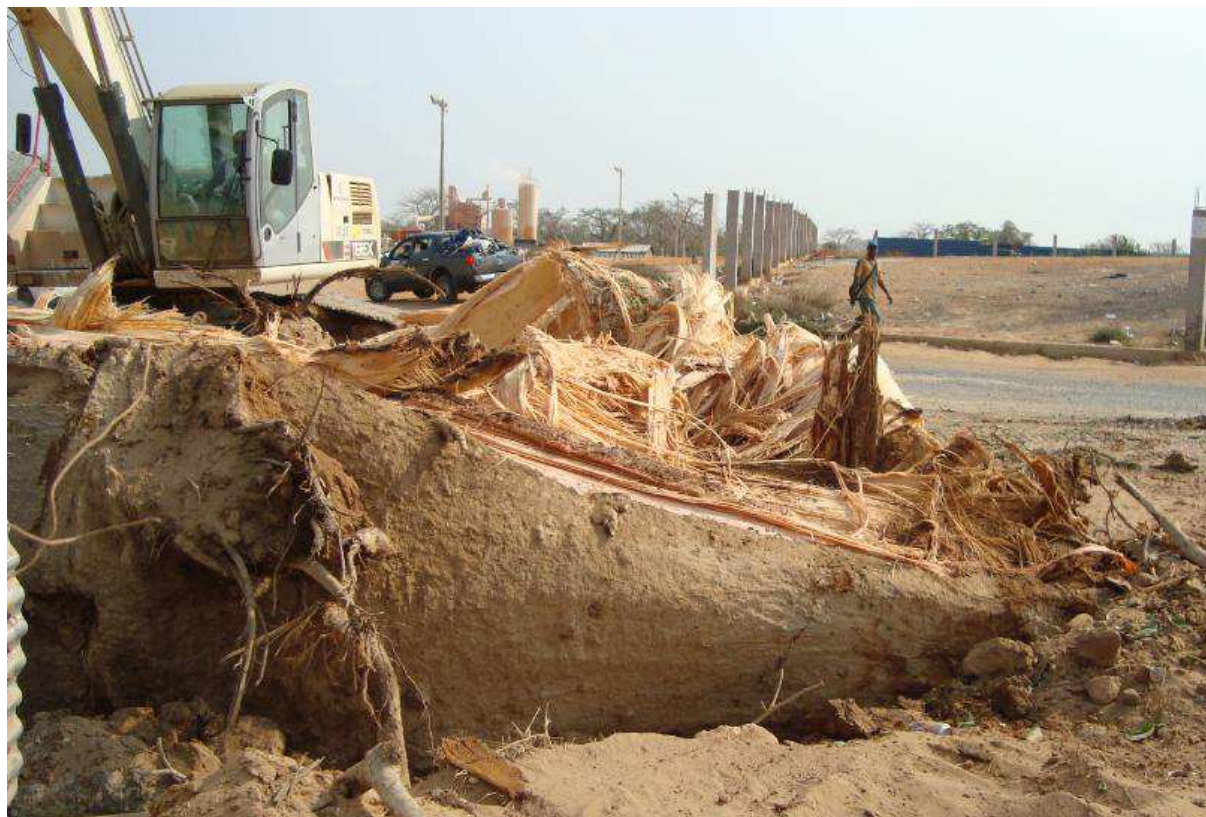
Figura 21: Máquinas fazendo derrubada de árvores no entorno do Córrego Cambambe na Honga. Foto do Autor
