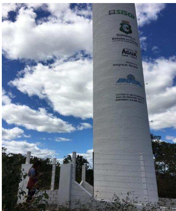
Figura 4- Reservatório elevado - Assentamento 10 de Abril
