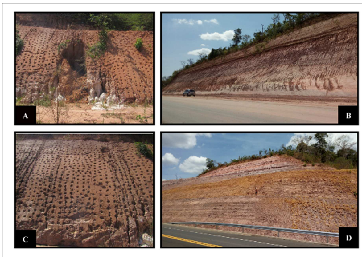
Figura 04 – Mosaico dos taludes de alguns trechos do rodoanel
