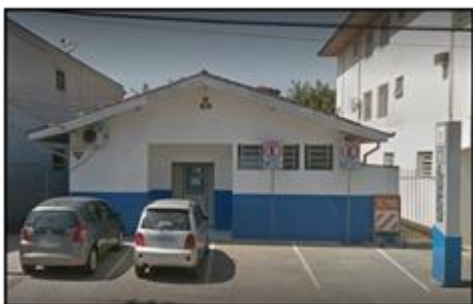
Figura 1: Fachada Frontal da Subprefeitura Sudeste.
