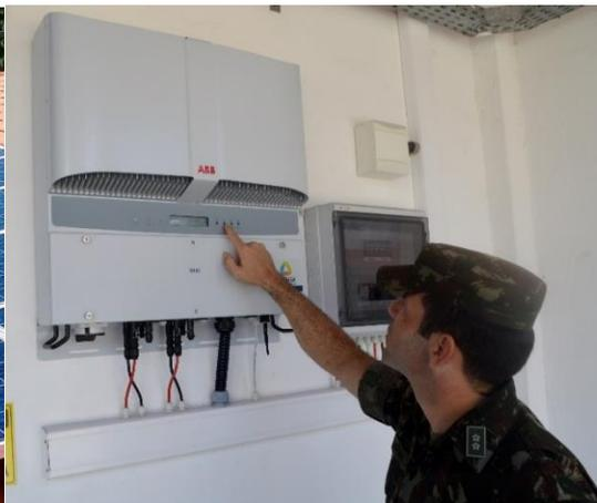
Figura 4: A - Sistema fotovoltaico instalado no telhado do Batalhão; B – Leitura da geração de energia elétrica através do medidor digital do inversor no 7º BE Cmb (Natal/RN)
