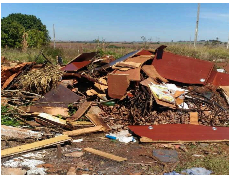
Figura 10 - Resíduos de construção civil e recicláveis diversos
