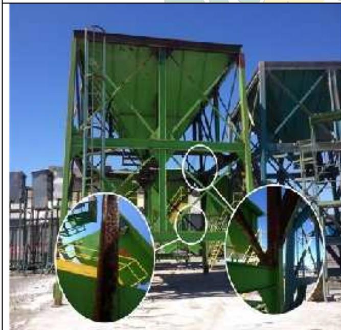
f) Nas estruturas é averiguado corrosão generalizada (uniforme e corrosão por placas). Esta corrosão ocorre em alguns locais específicos da estrutura do funil, formando placas com escavações.
