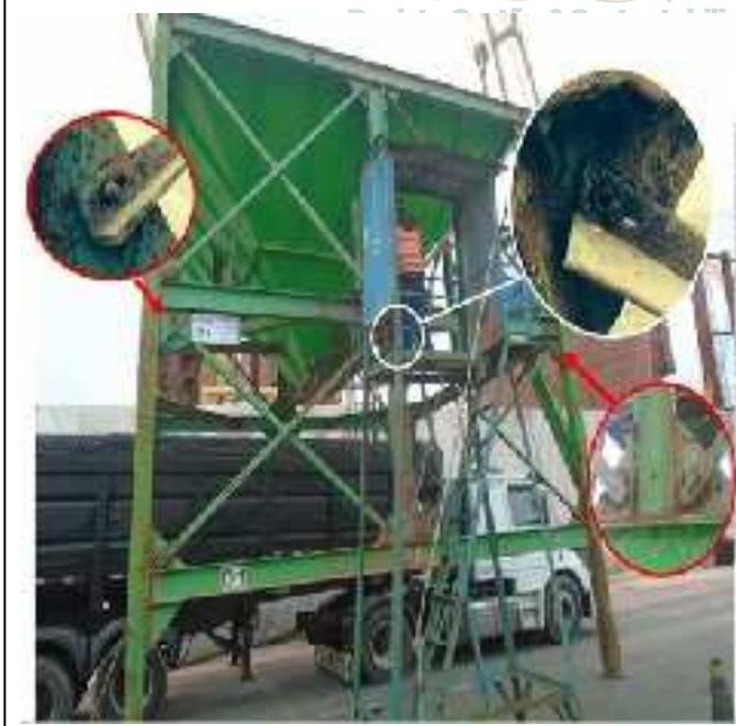
d) Nos funis verifica-se que nas junções das estruturas existe corrosão por frestas.
