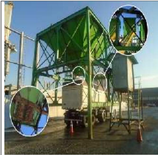
e) No sistema de abertura do funil, local onde delimita a quantidade de carga a ser transportada pelo veículo, se observa corrosão filiforme e por erosão, visto que o método protetivo é severamente danificado pelo atrito das cargas.
