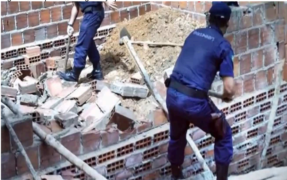
Figura 5. Empresa de segurança privada derrubando imóvel de morador no CIPS.
