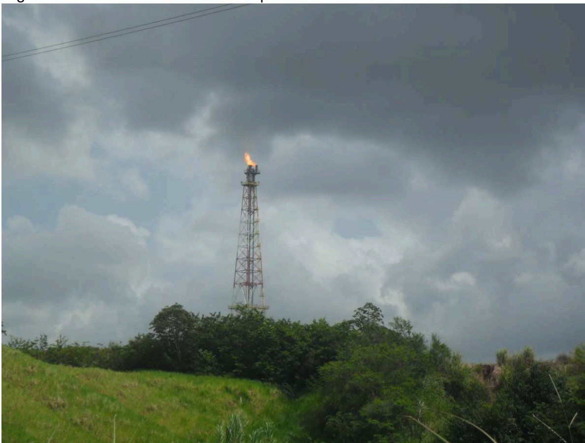
Figura 3. Torre de fracionamento de petróleo da Refinaria Abreu e Lima
