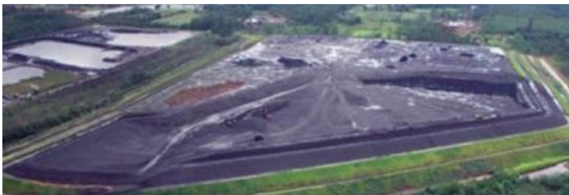
Figura 1: Barragem de disposição e controle do resíduo de carvão mineral.
