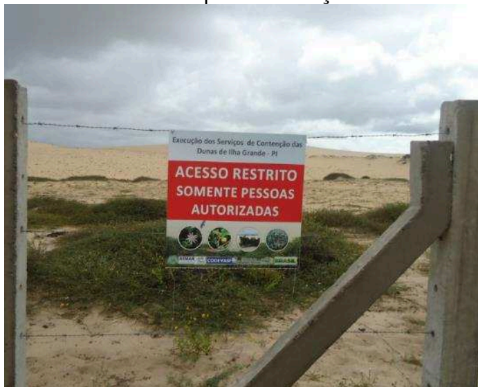
Figura 11 – Cercamento da área para contenção de dunas em Ilha Grande
