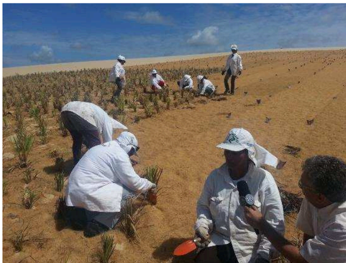
Figura 13 – Plantio do capim açu sobre biomantas fixadas nas dunas em Ilha Grande
