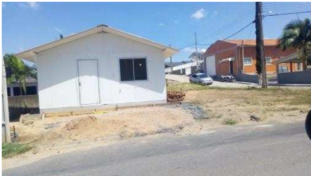
Figura 6 - Casa recuperada pela Defesa Civil
