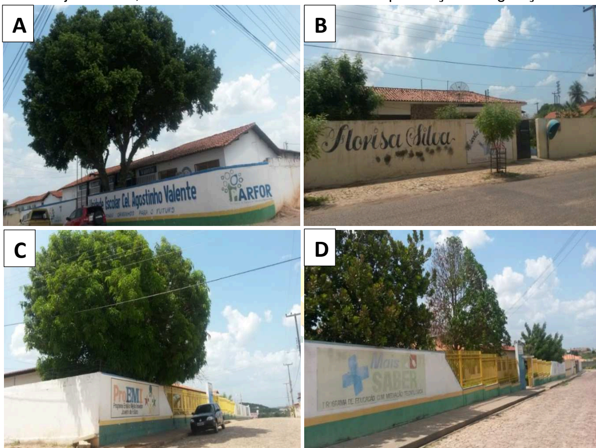
Figura 1. Fachada das escolas: A – Unidade Escolar Cel. Agostinho Valente, imagem B – Unidade Escolar Floriza Silva, imagem C – U. E. Nonato Valente e imagem - D a U. E. Beija Valente, demonstrando a estrutura física e a presença de vegetação.
