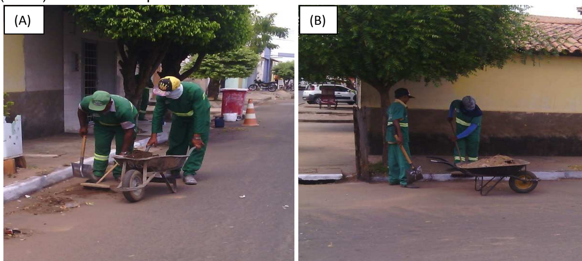
Figura 3 - Aspecto visual do trabalho de funcionários do serviço público de limpeza (A e B) sem EPI adequados
