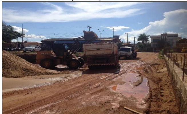
Figura 12: Máquinas pesadas em operação que emitem ruídos e incomodam a circunvizinhança. Empresa A. Altamira – Pará.
