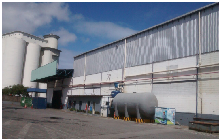
Figura 4: Estação de Tratamento de Reuso de água pluvial.
