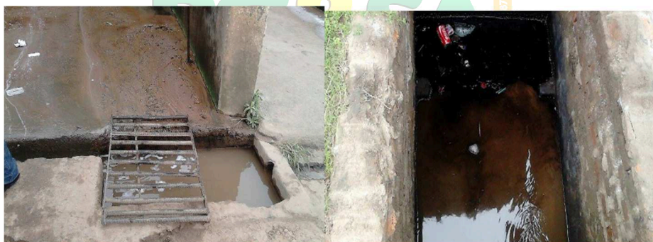
Figura 3 - Disposição inadequada dos resíduos da lavagem de veículos.
