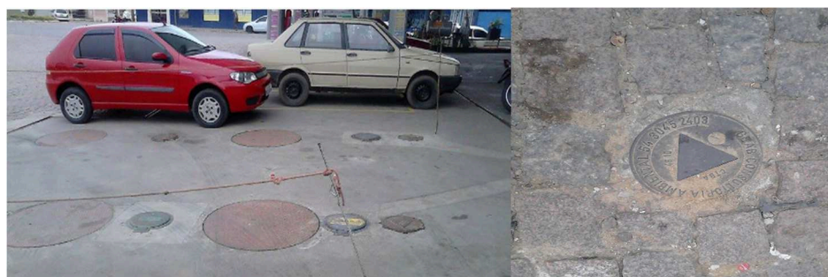
Figura 1 - Tanques de armazenamento e poço de monitoramento do combustível (respectivamente).
