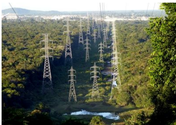
Figura 1 – Exemplo de impacto ambiental negativo na implantação de LTs. Limpeza de faixa de servidão para implantação de LT da COPEL.
