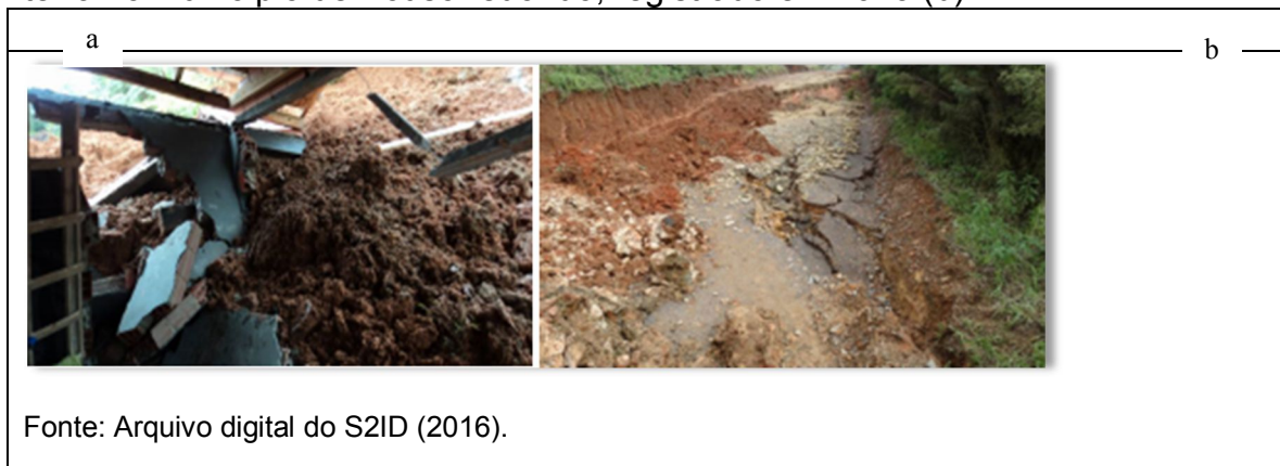
Figura 4- Residência atingida por deslizamento de terra no município de Ituporanga, registrado em em 22 de setembro de 2013 (a). Deslizamento de terra no município de Pouso redondo, registrado em 2013 (b).
