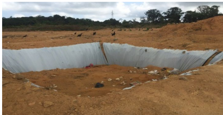
Figura 2 - Foto Vala séptica para resíduo patológico com impermeabilização
