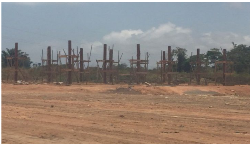
Figura 4 – Obras do galpão para triagem de resíduos
