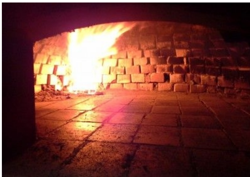
Figura 2 – Queimador a Pellet em funcionamento.
