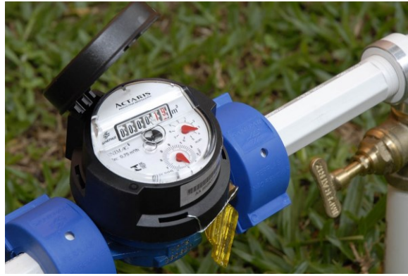
Figura 4. Hidrômetro instalado
