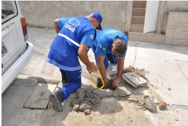
Figura 5: Identificação de furto de água.
