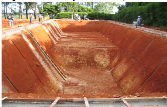
Figura 3 – Escavação de célula para o Biodigestor.
