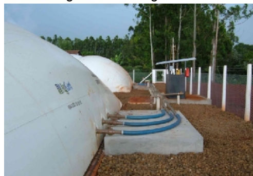
Figura 4 – Biodigestores instalados.
