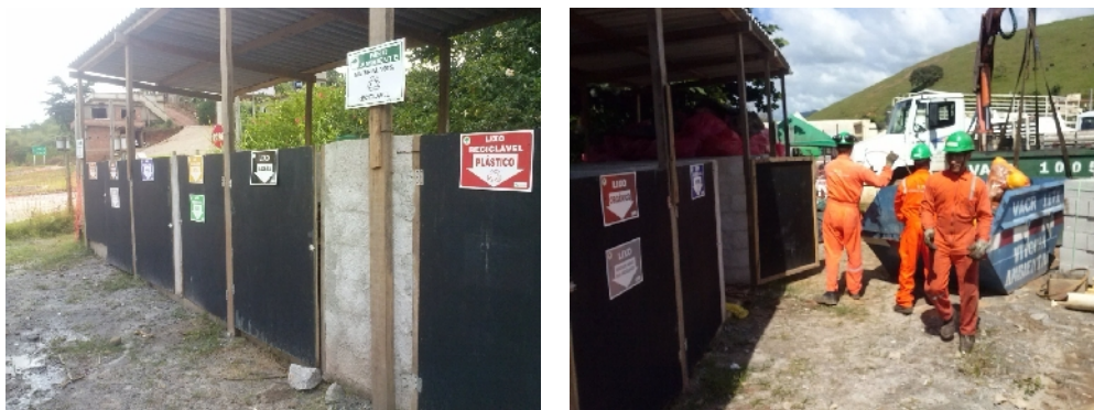
Figura 02: Armazenamento em canteiro estratégicos e recolhimento dos resíduos. Do autor (2013)
