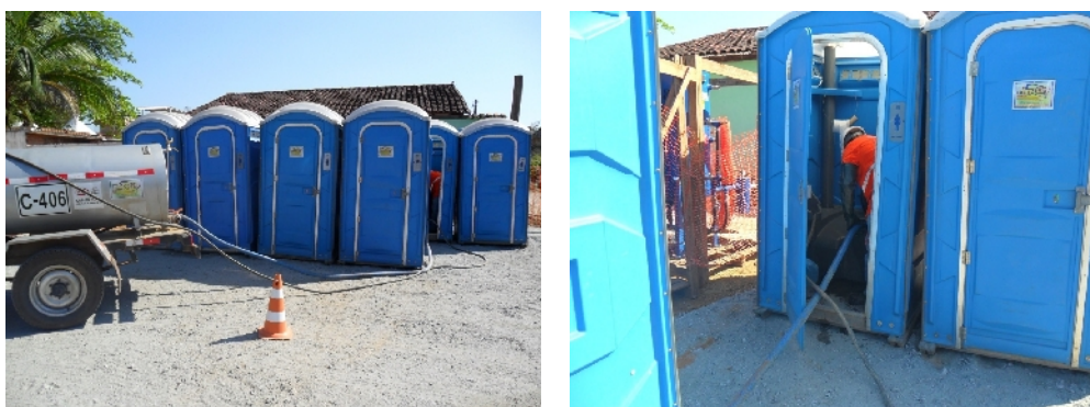
Figura 03:Recolhimento dos efluentes dos banheiros químicos das obras de dutos. Do autor (2013)
