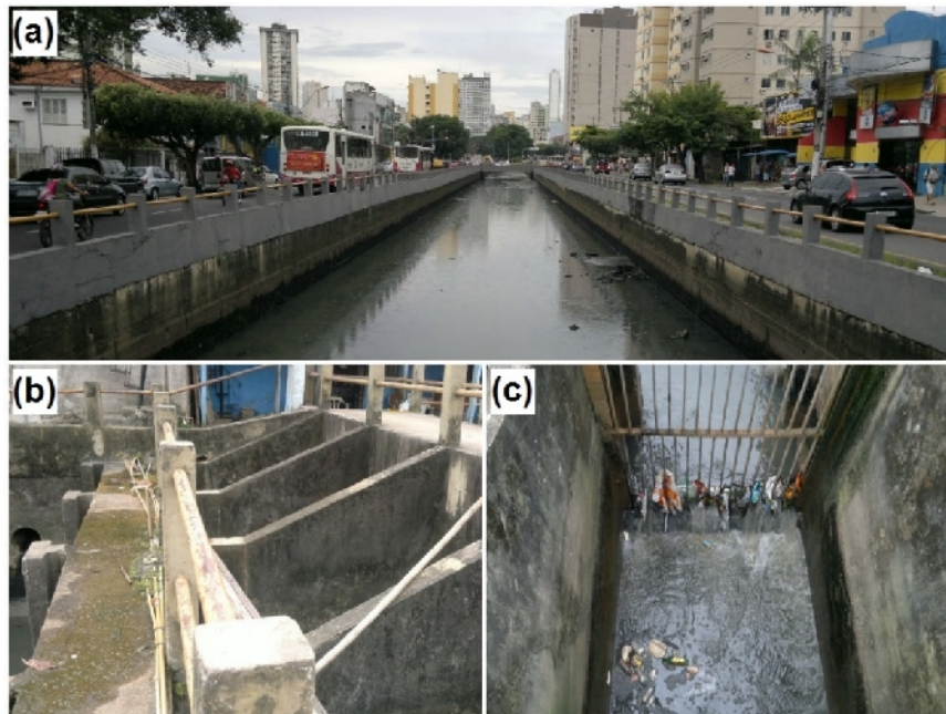
Figura 4 – (a) Canal da Tamandaré; (b) Comportas; (c) Gradeamento. Fonte: Autor, 2013.
