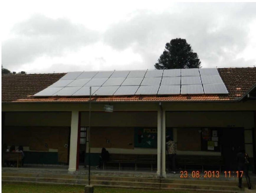
Figura 16: Instalação de 27 módulos fotovoltaicos (p-Si) na cobertura da escola
