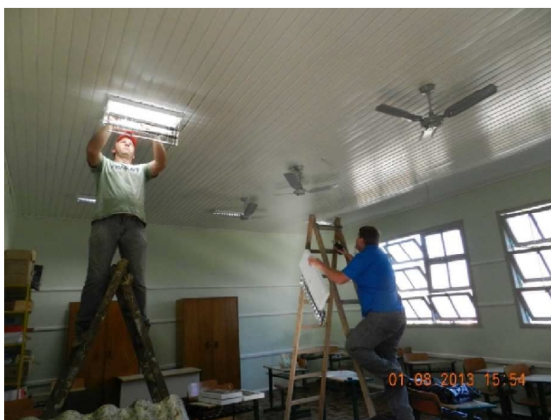
Figura 14: Instalação das luminárias mais eficientes.
