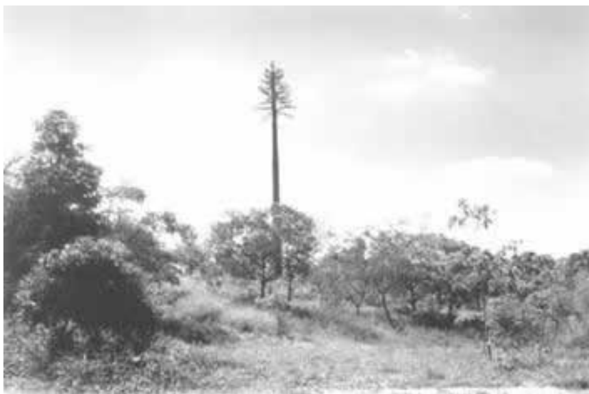
Figura 3: Torre camuflada da UFMG.
