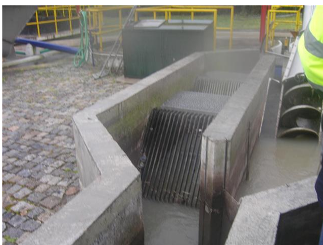
Figura 12: Sistema de gradeamento.
