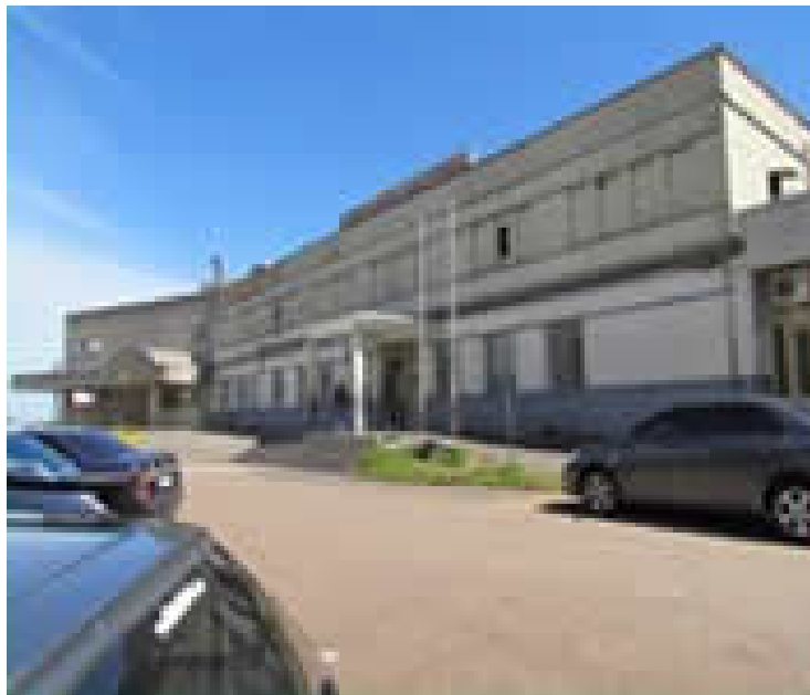
Figura 9- Fundação Hospitalar de Sapucaia do Sul- Sapucaia do Sul- RS.
