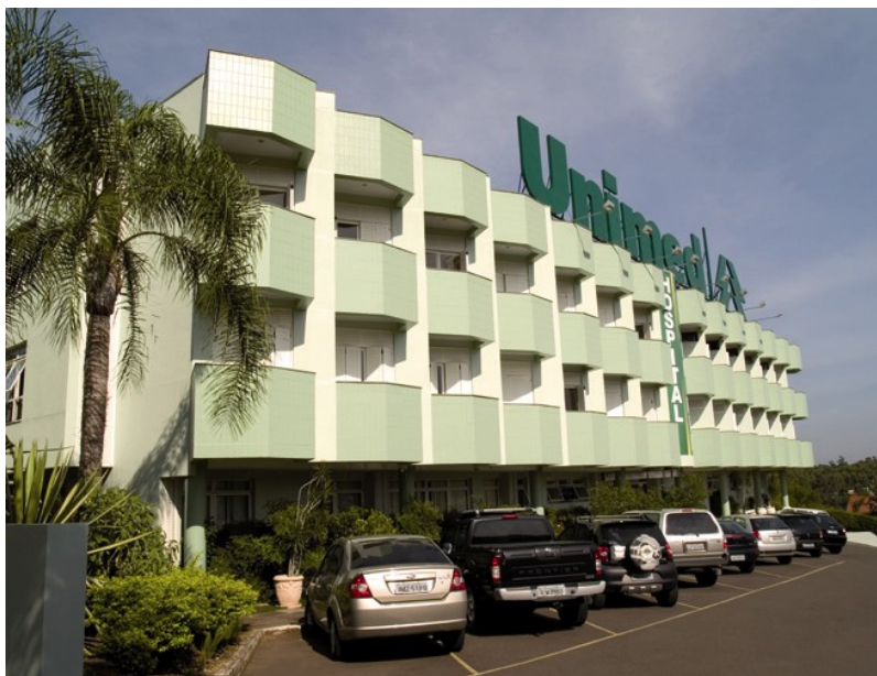
Figura 7- Hospital Unimed- Novo Hamburgo- RS.
