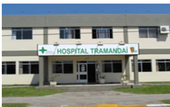
Foto 1: Fachada do Hospital Tramandaí – Entrada principal Localizada na Av. Emancipação, 1255 – Bairro: Centro Tramandaí – RS. Fonte: www.fhss.com.br
