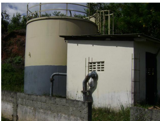
Figura 07 – Estação de captação e distribuição. Fonte: Juliano Marcelo Honorato (2012)
