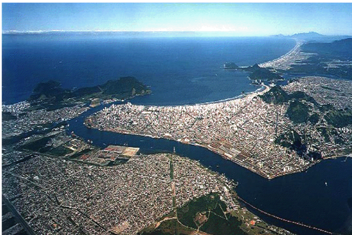
Figura 2: Vista aérea do Porto de Santos.
