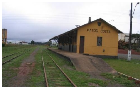
Figura 10 – Estação Matos Costa. Fonte: Estações Ferroviárias, 2005.
