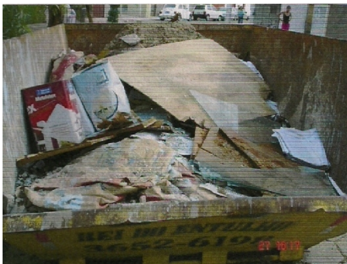
Figura 5.2 – Pontos de Remoção - Caçamba da empresa Rei do Entulho. Fonte: Elaboração do autor, 2010.
