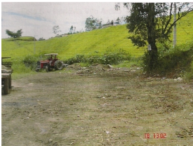
Figura 5.4 – Disposição irregular de RCD - Jardim Campo Grande – Caçapava-SP Fonte: Elaboração do autor, 2010.
