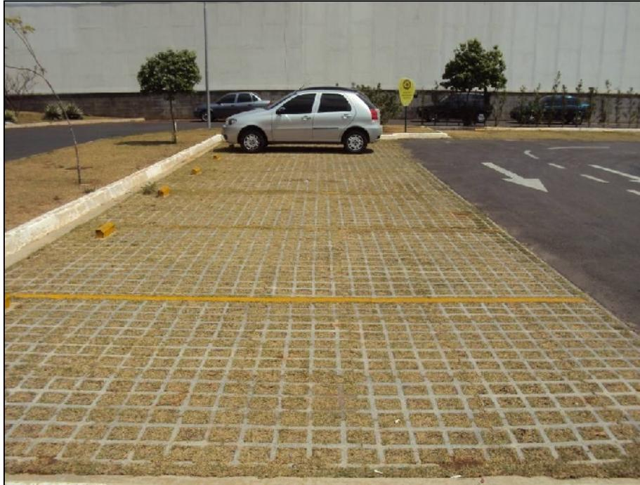
**Figura 4** – Vagas do estacionamento confeccionadas em blocos vazados.
