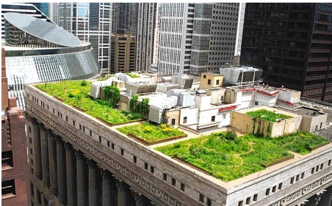
FIGURA 6.1 – Telhado verde Fonte : City Hall Chicago
