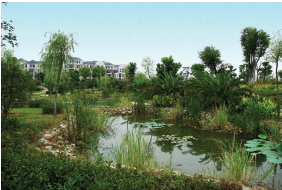
FIGURA 7 – Jardins Filtrantes para tratamento de esgoto.
