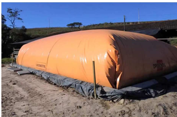
Figura 6. Biodigestor modelo canadense. Fonte: EPAGRI, 2021.
