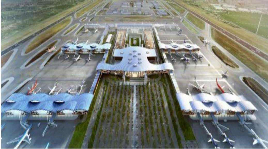
Figura 5 - Vista do Terminal do Aeroporto de Santiago no Chile
