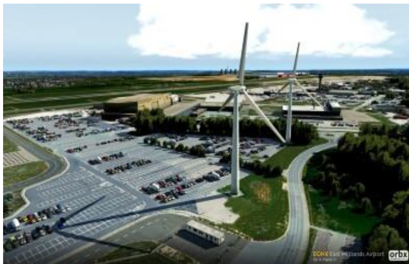
Figura 15 - Aerogeradores de Energia Eólica- Aeroporto de East Midlands- Inglaterra
