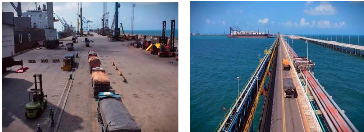
Figura 4 – Caminhões transportando carga a granel com lonas de proteção
